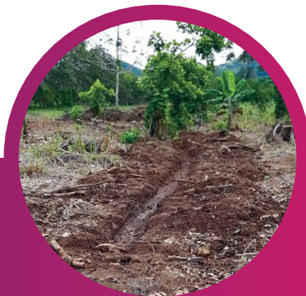
Figura 2. Construcción de drenaje para la salida de agua durante la preparación del terreno
